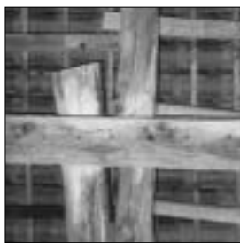
Copertura zona portico.
