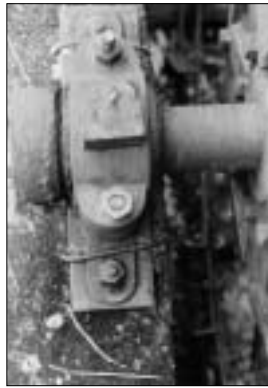
Particolare dell'asse della ruota idraulica.
