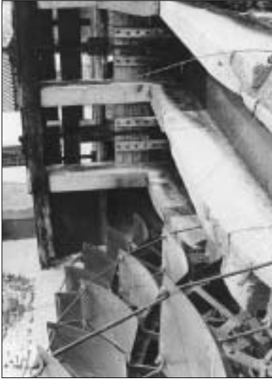
Sistema di regolazione della portata d'acqua con le paratoie in legno e i canali di deflusso o "spazzere" in sasso.
