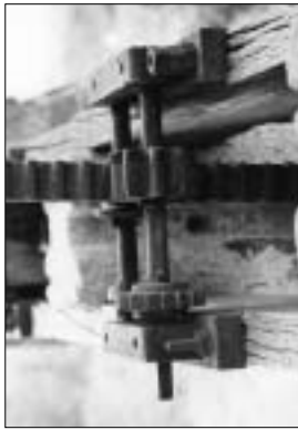
Ingranaggio delle paratoie in legno che regolano l'afflusso di acqua alla ruota idraulica.
