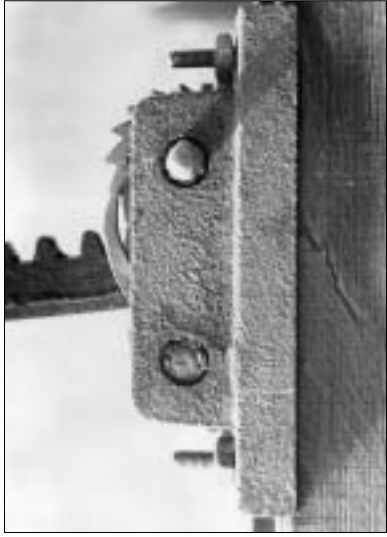
Particolare dell'innestaggio delle paratoie: è ben visibile il fermo in metallo che blocca la ruota dentata e sostiene la paratoia in legno.
